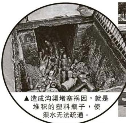
▲造成沟渠堵塞祸因，就是堆积的塑料瓶子，使渠水无法疏通。
